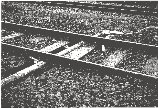
Bild 2: Dampfleitungsführung im Gleisbereich (unter Betriebsgleisen)
