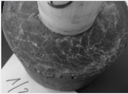
Abb. 8 Rissbild eines Prüfkörpers mit 28 Tagen Abbindezeit nach 12 Frost-Tau-Wechseln
