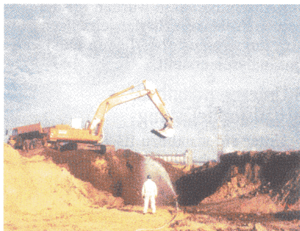
Abb. 6: Befeuchtung des Aushubbereichs
