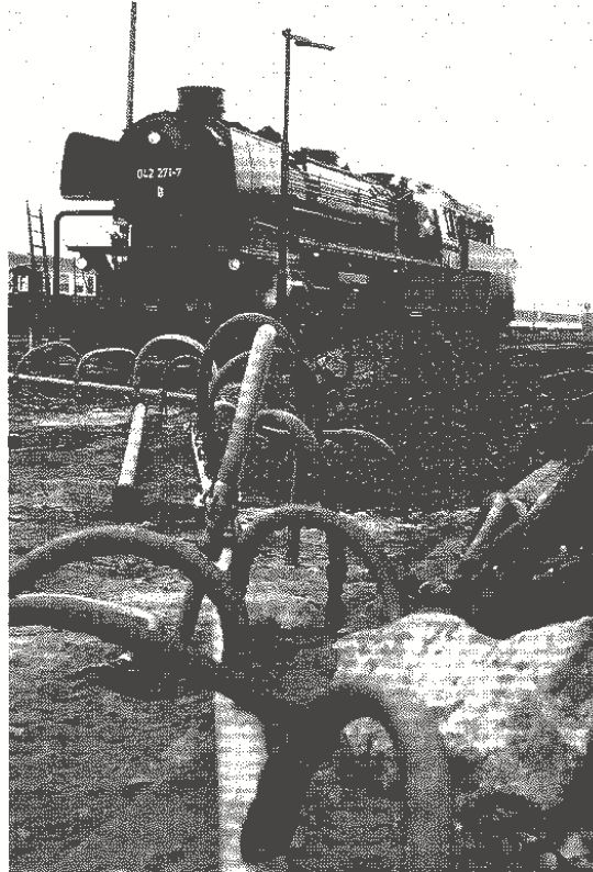
Bild 3: Äußerer Ring zur Grundwasserabsenkung
